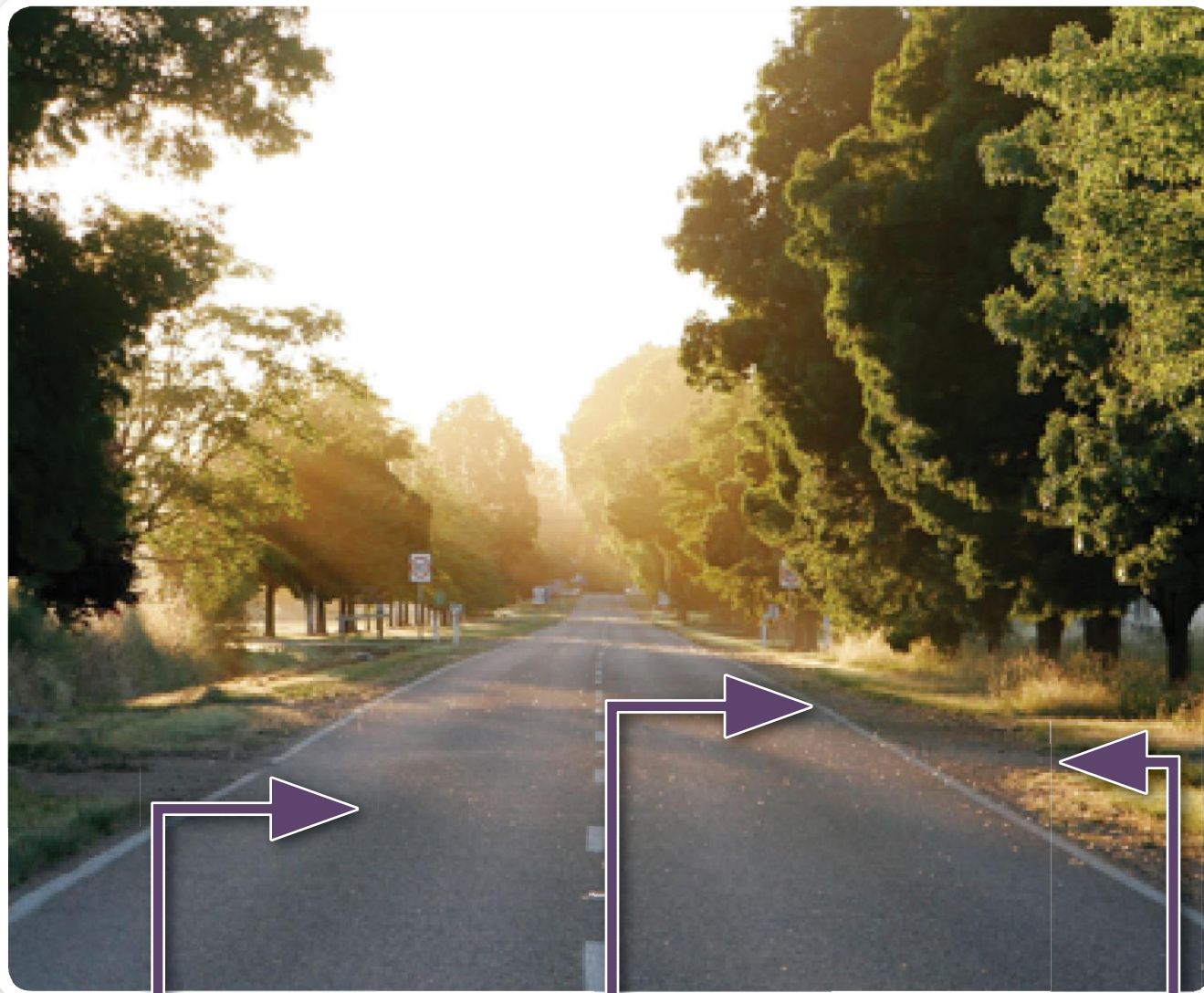
La Chaussée (voie + accotement)
